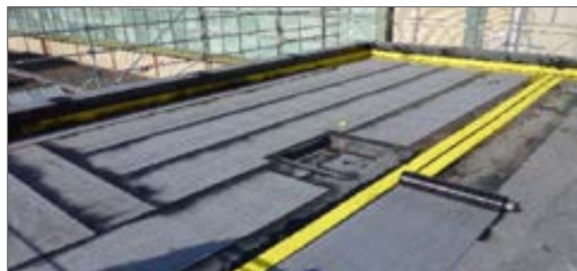
Einfacher sandwichtypiger Einbau zwischen zwei Dichtungsbahnen
